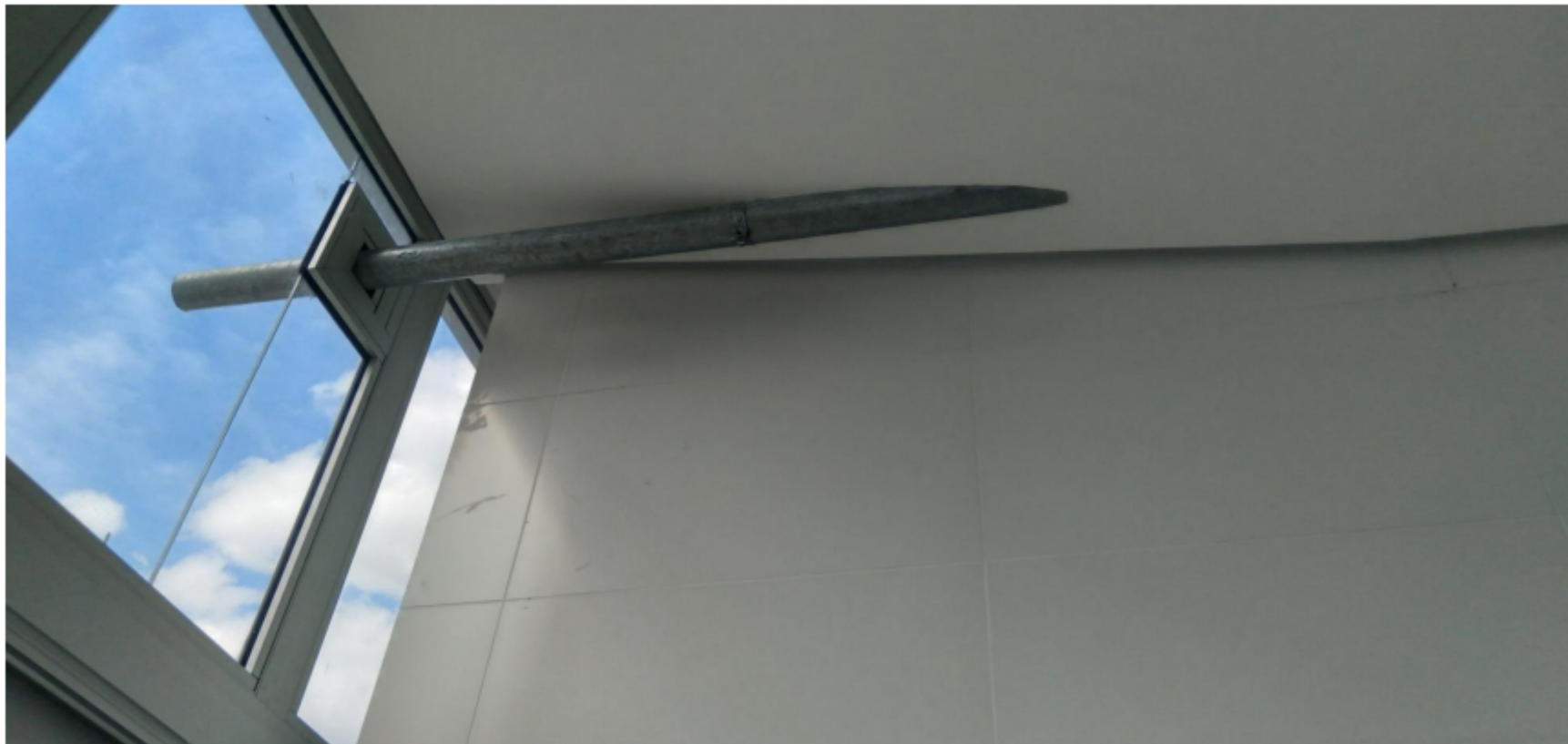
Foto XVI: Banheiros internos dos funcionários
