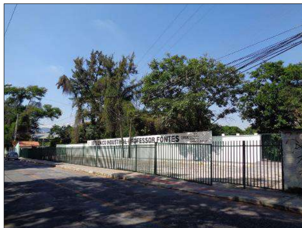
Figura 63 – Escola Técnico Industrial. Fonte: Ecominas, 2019.
