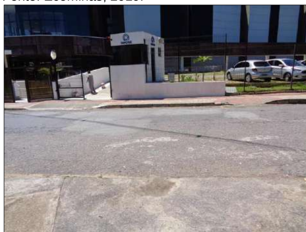
Figura 167 – Travessia, sem faixa de pedestres, na Rua Sete.
