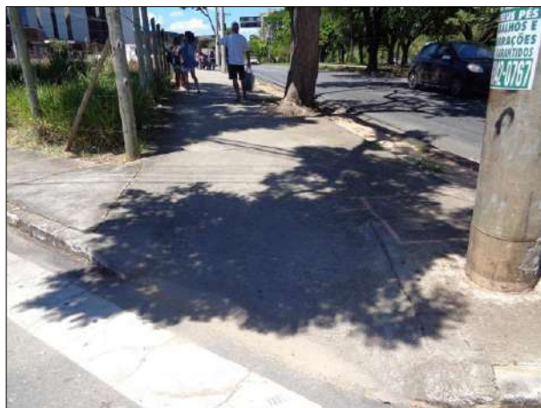
Figura 118 – Continuação do caminhar pela calçada da Av. José Cândido da Silveira. Fonte: Ecominas, 2019.
