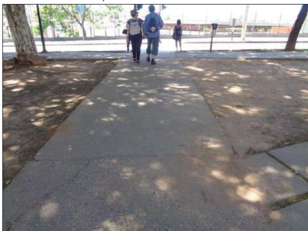
Figura 113 – Vista da travessia dos pedestres na calçada do canteiro central, da Av. José Cândido. Fonte: Ecominas, 2019.
