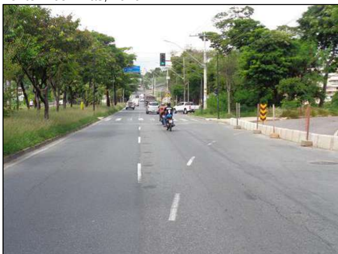
Figura 201 – Vista da sinalização na aproximação E. Fonte: Ecominas, 2019.
