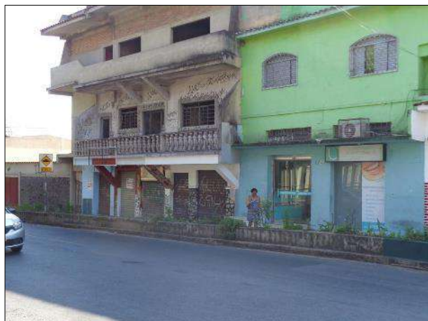
Figura 74 – Edifícios de uso misto na Rua Gustavo da Silveira.
