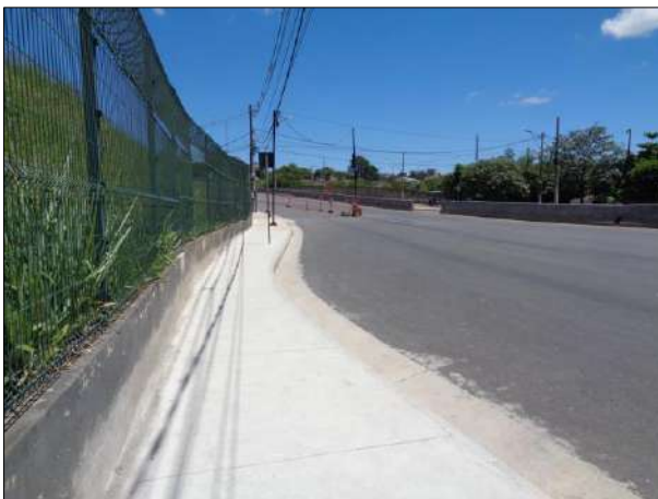
Figura 132 – Continuação do caminhamento pela calçada da Rua Gustavo da Silveira.
