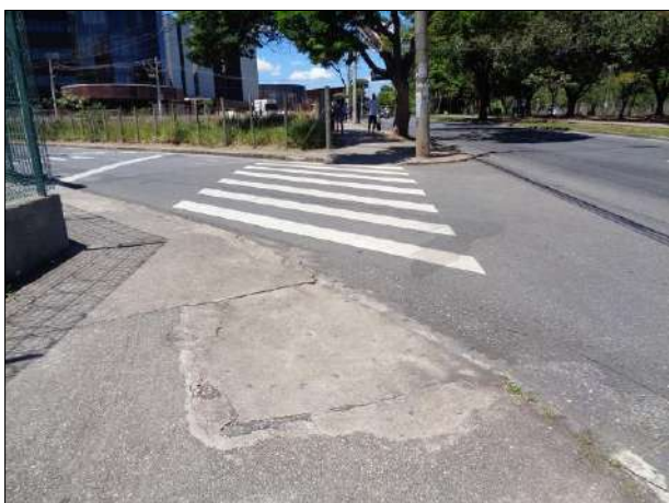
Figura 140 – Travessia na faixa de pedestres na Rua Sete.
