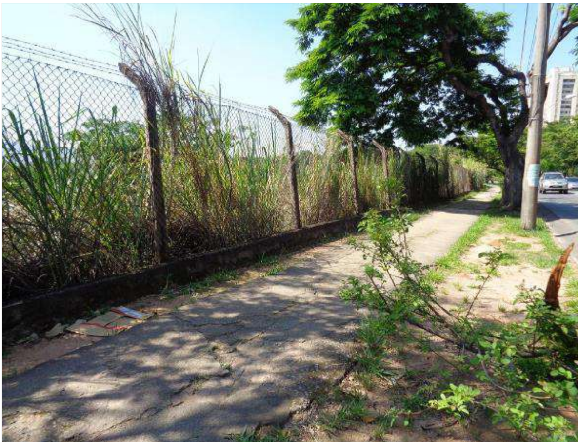
Figura 56 – Fachada do empreendimento (Av. José Cândido da Silveira). Fonte: Ecominas, 2019.
