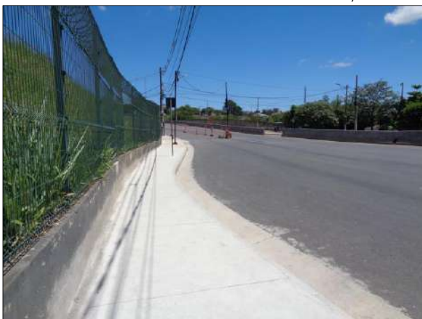
Figura 154 – Continuação do caminhamento pela calçada da Rua Gustavo da Silveira. Fonte: Ecominas, 2019.
