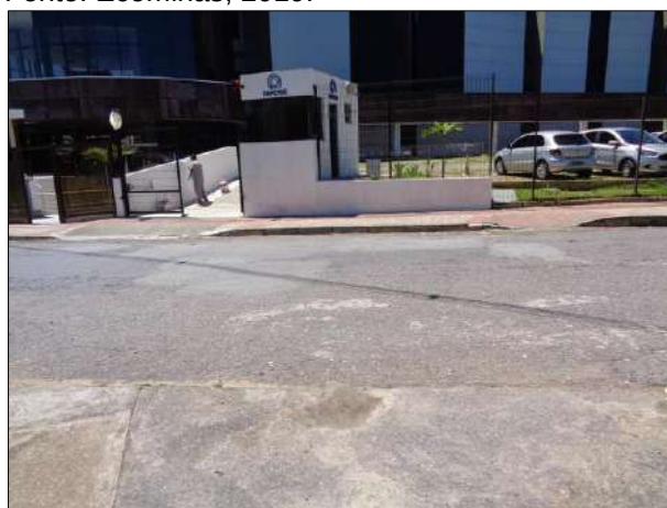
Figura 145 – Travessia, sem faixa de pedestres, na Rua Sete.
