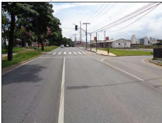
Figura 200 – Vista da sinalização na aproximação D. Fonte: Ecominas, 2019.
