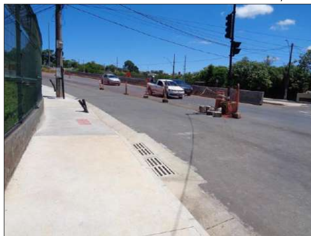
Figura 155 – Continuação do caminhamento pela calçada da Rua Gustavo da Silveira. Fonte: Ecominas, 2019.
