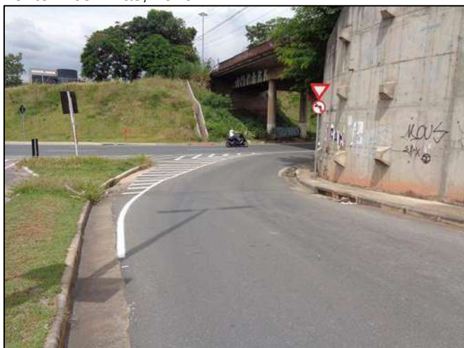
Figura 199 – Vista da sinalização na aproximação C. Fonte: Ecominas, 2019.
