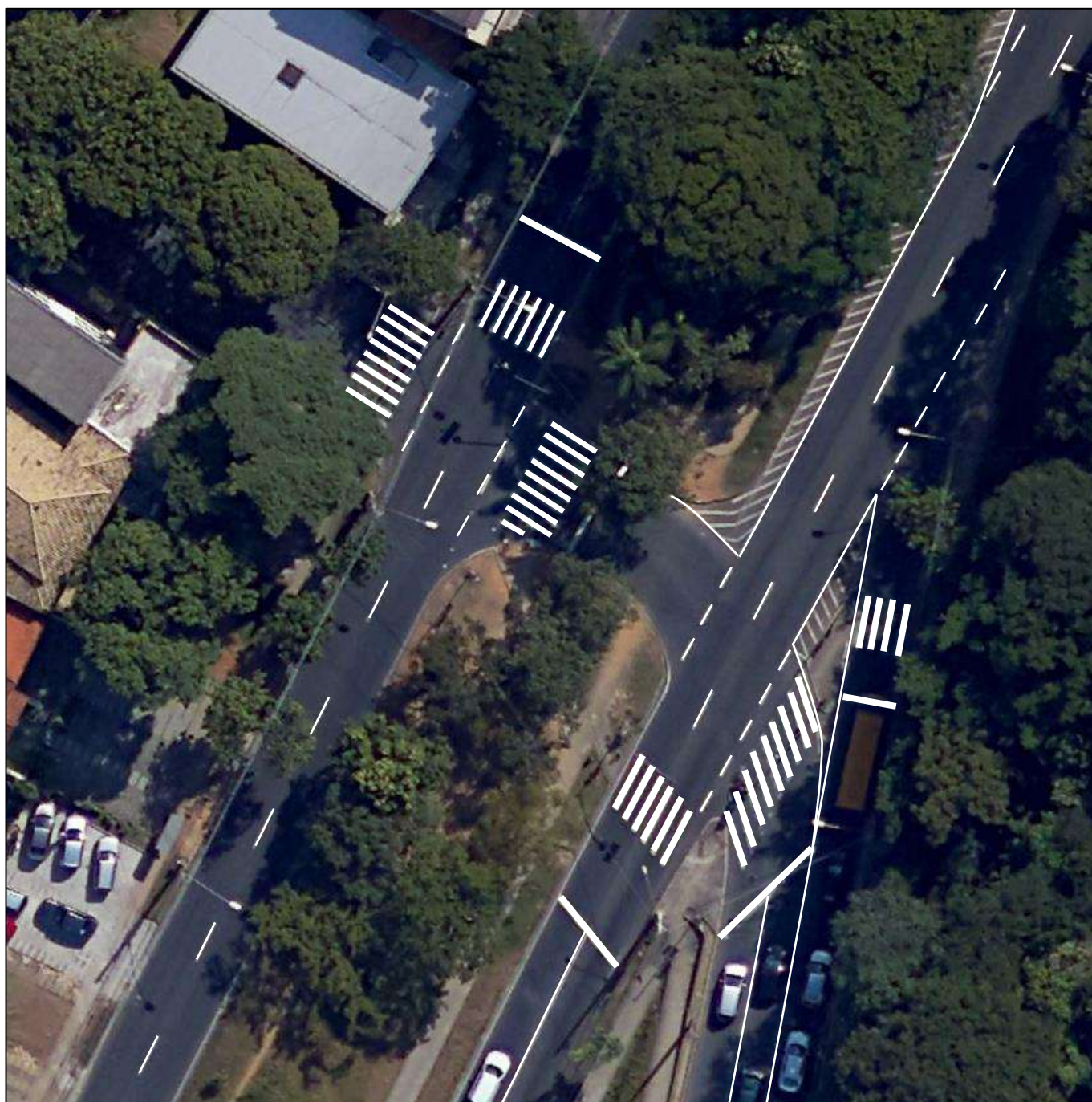
Figura 179 – Continuação da sinalização horizontal com as faixas de trânsito na Interseção 01.
