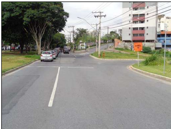
Figura 203 – Vista da sinalização na aproximação G. Fonte: Ecominas, 2019.
