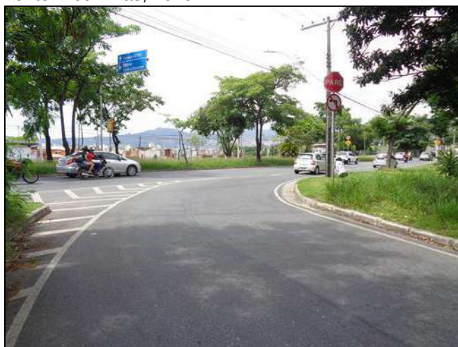
Figura 202 – Vista da sinalização na aproximação F. Fonte: Ecominas, 2019.
