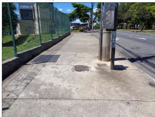
Figura 116 – Vista do caminhamento pela calçada da Av. José Cândido da Silveira. Fonte: Ecominas, 2019.
