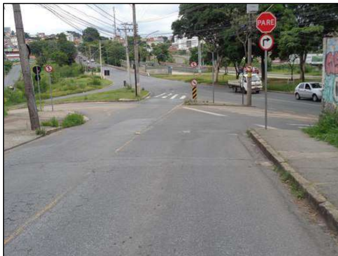
Figura 204 – Vista da sinalização na aproximação H. Fonte: Ecominas, 2019.
