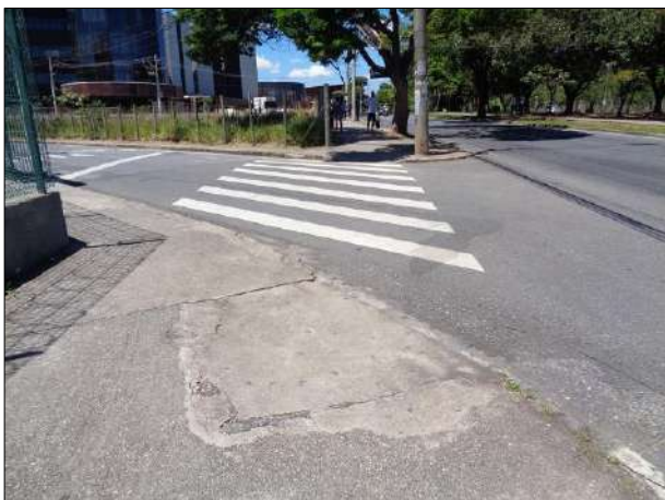
Figura 162 – Travessia na faixa de pedestres na Rua Sete.
