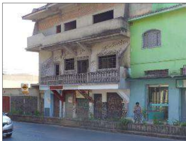
Figura 97 - Pichações em edificação na VM. Fonte: Ecominas, 2019.
