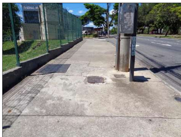
Figura 161 – Continuação do caminhamento pela calçada da Av. José Cândido da Silveira.
