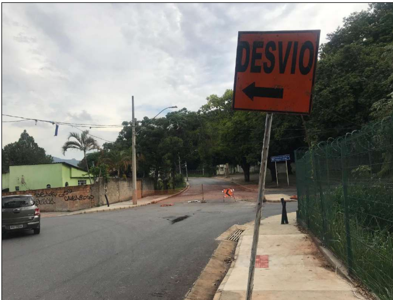
Figura 210 – Vista da interdição e desvio da Rua Gustavo da Silveira para a Rua Conceição do Pará. Fonte: Ecominas, 2019.
