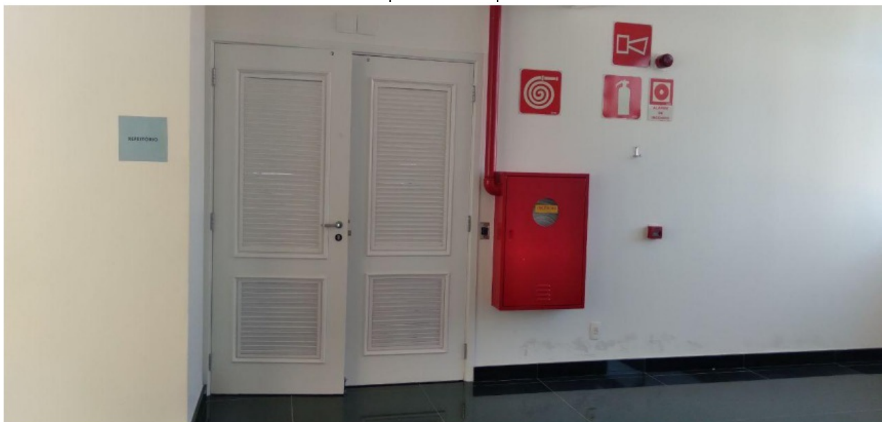
Foto II: Entrada dentro do prédio vista de dentro do restaurante
