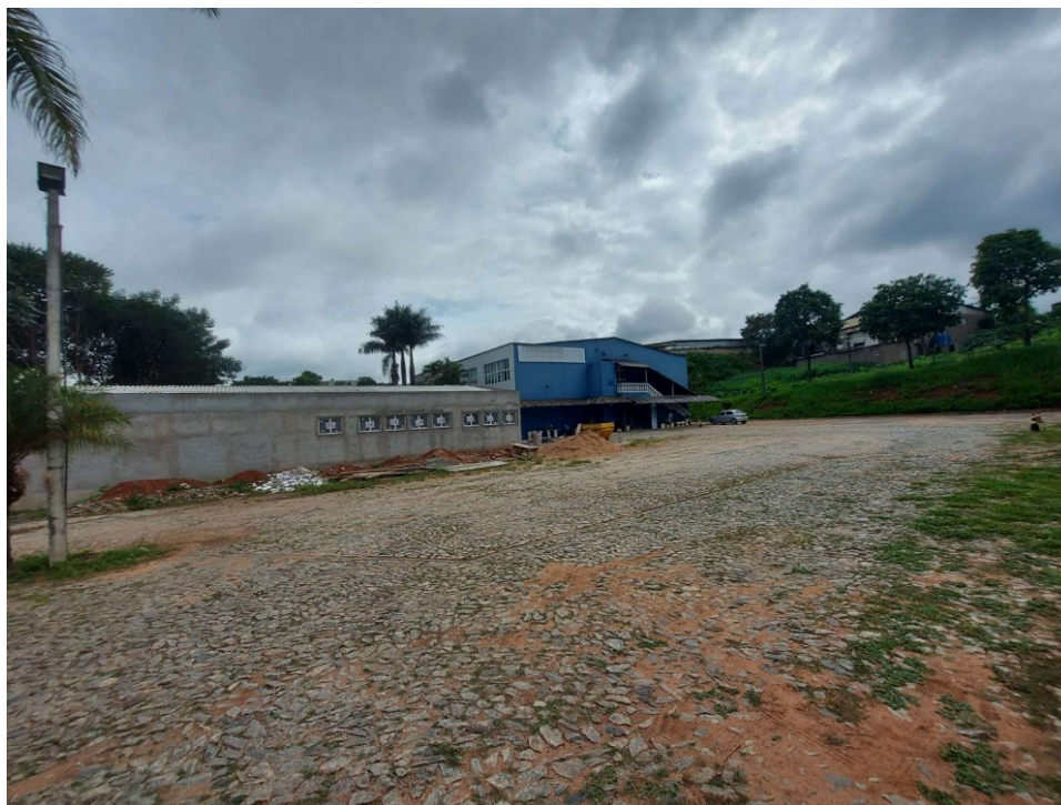
Imagem 01: Vista da edificação principal, ao fundo, e do Módulo 1, à frente
