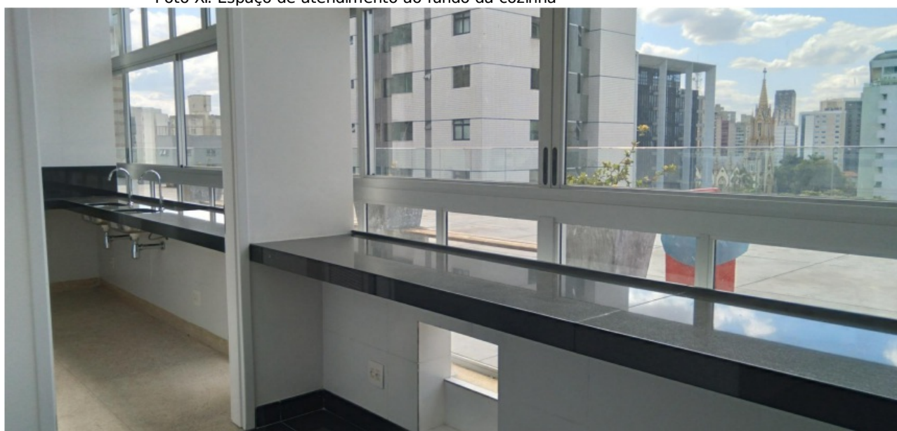
Foto XII: Teto do espaço de atendimento com iluminação diferenciada
