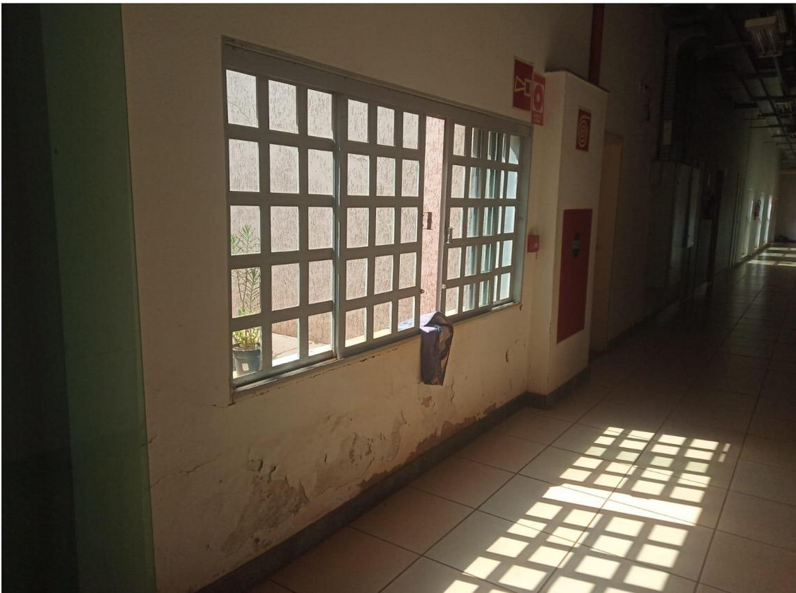
Para as **paredes** internas será feito o emassamento parcialmente das paredes na altura de 1,50, conforme necessário, e na altura de 1,50 sera feito a pintura esmalte em superfície de concreto/alvenaria, assim definido que isso trará qualidade e durabilidade para a pintura, visto que são áreas que recebem mais
