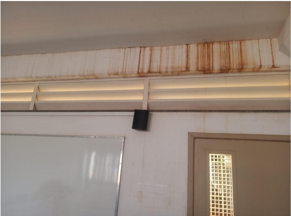
Para as **paredes externas** será passado uma camada de textura rolada, recompondo a que já existe para garantir a durabilidade, que por não receber manutenção se desgastou ao longo do tempo, sendo necessário a recomposição, e posteriormente demão de uma tinta acrílico ( com as cores escolhidas).
